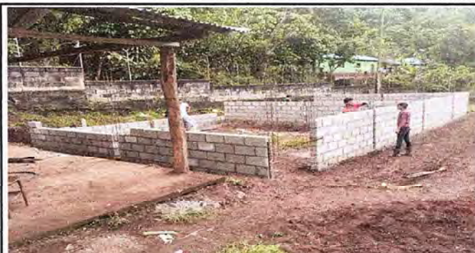
Foto 2: Vista del lugar en donde se colocaran las puertas de acceso de los estudiantes dentro de las diferentes aulas a realizar.
