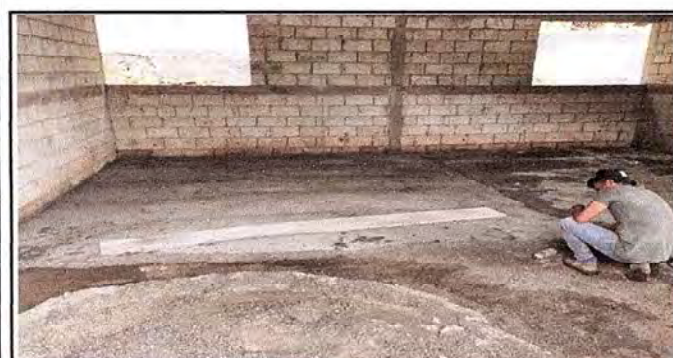
Foto 5: Vista del cambio de piso a las aulas culminadas.
