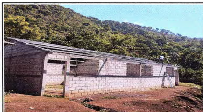
Foto 3: Vista de la instalación de las costaneras.
