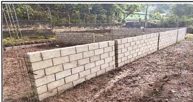
Foto 1: Vista de los trabajos realizados de la continuidad de las aulas a realizar.
