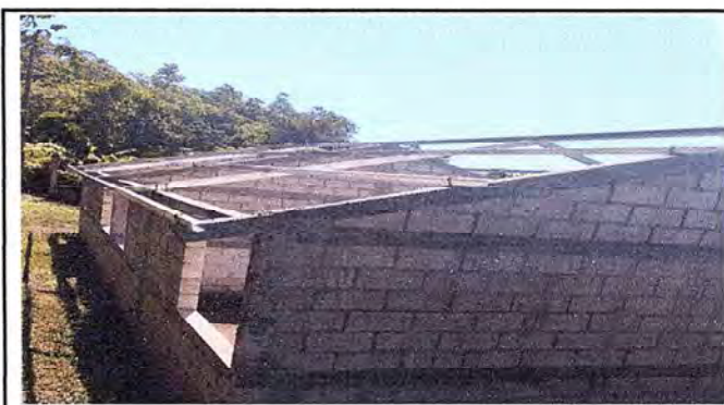
Foto 4: Estructura finalizada de las costaneras.
