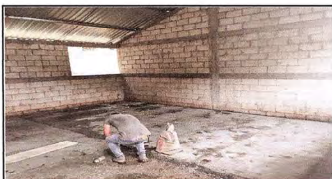
Foto 6: Enlizado de piso de las aulas.
